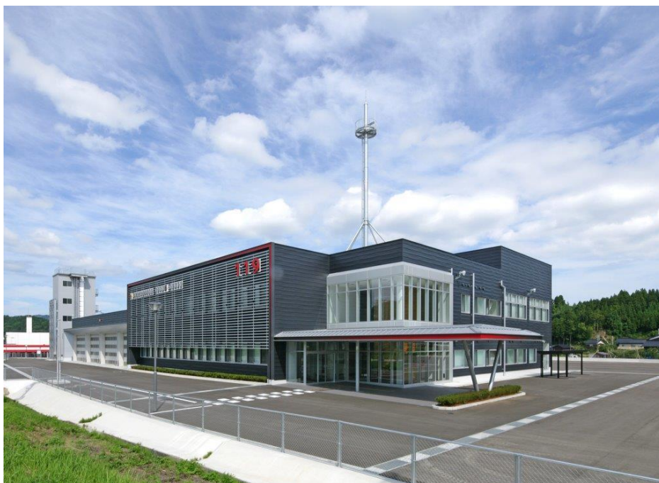
消防本部・輪島消防署
