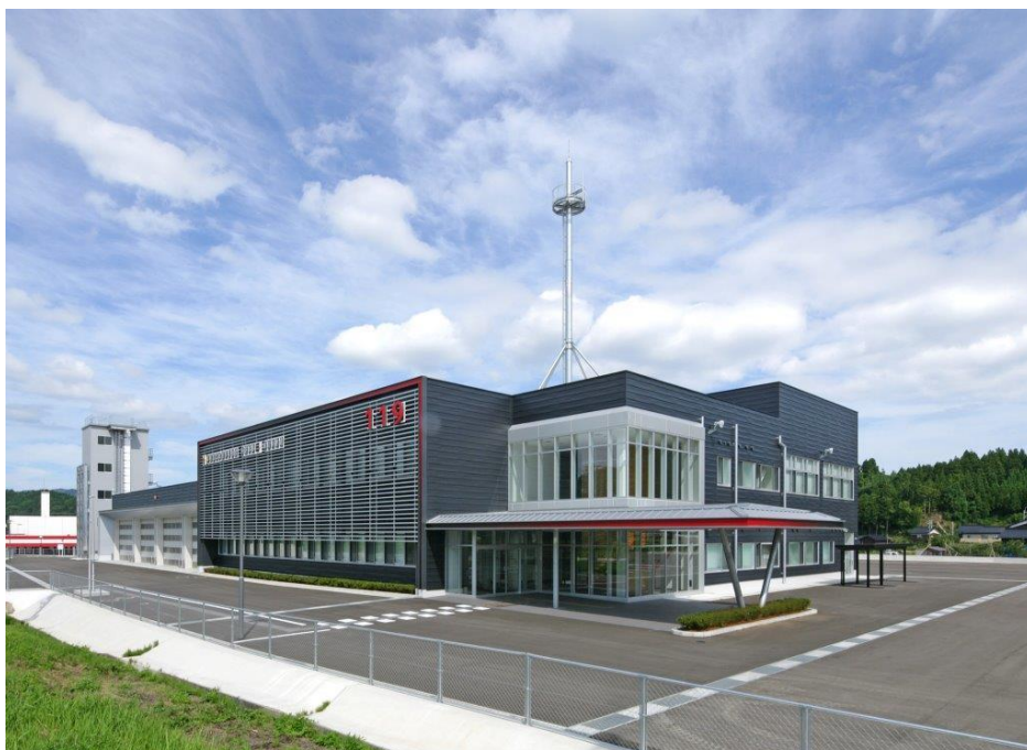
消防本部・輪島消防署
